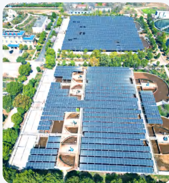
全椒污水厂光伏面板铺设图
