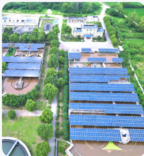
桐城城南污水厂光伏面板铺设图
